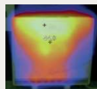
Acumulador de calor Temp. de superfície. 44,8 °C
