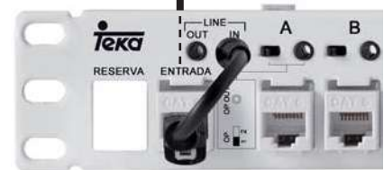
Ligação via cabo UTP ao Keystone primário do painel PC adicional
